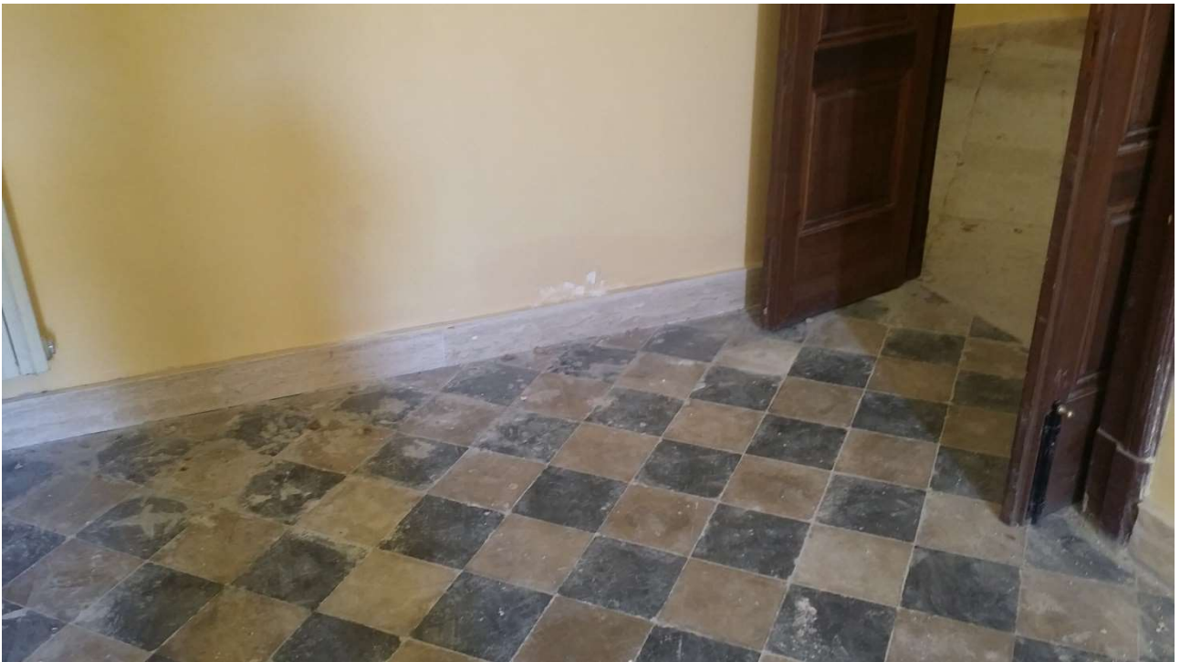
Pavimenti piano terra
