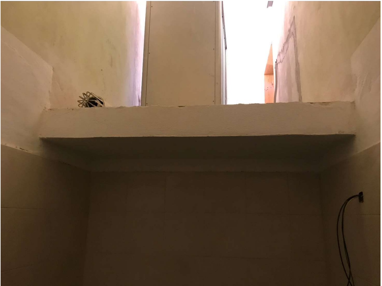
Solaio da demolire e parete da chiudere al primo piano
