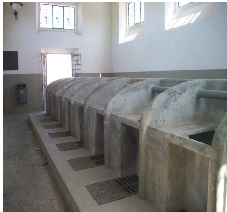
Visione delle varie postazioni che vi sono al Lavatoio.
